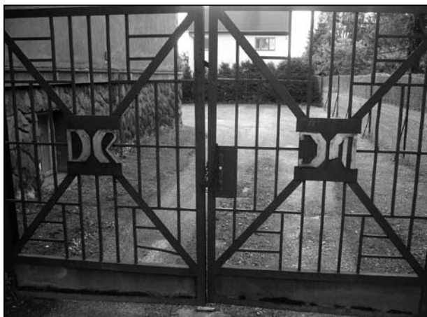
Původní jsou rovněž vchodová železná vrata, kde lze vidět iniciály MUDr. Jaroslava Mička „DR JM“.
